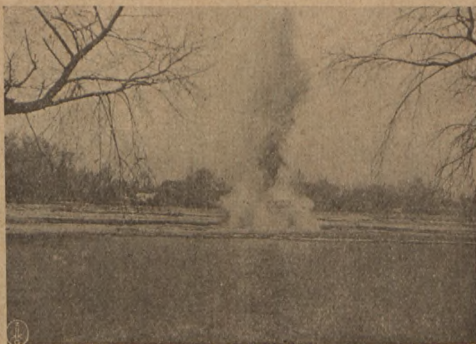
Wysadzanie zatorów lodowych na rzece.
