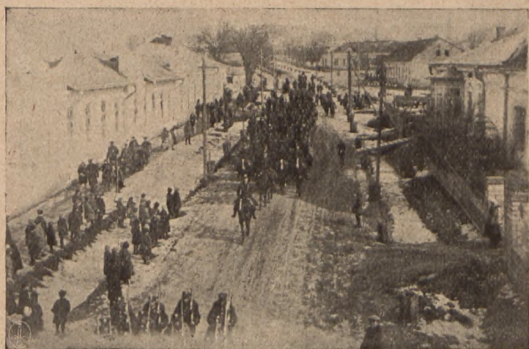
Defilada kawalerji „Kopu“.
