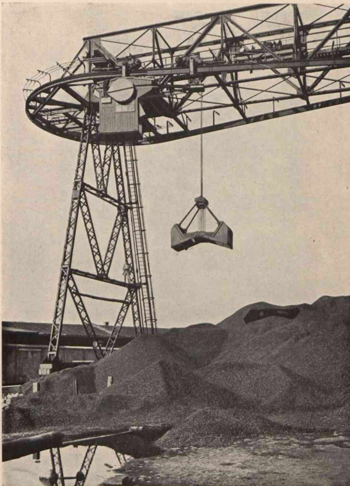
Fragment urządzeń do nawęglania w Elektrowni Łódzkiej
