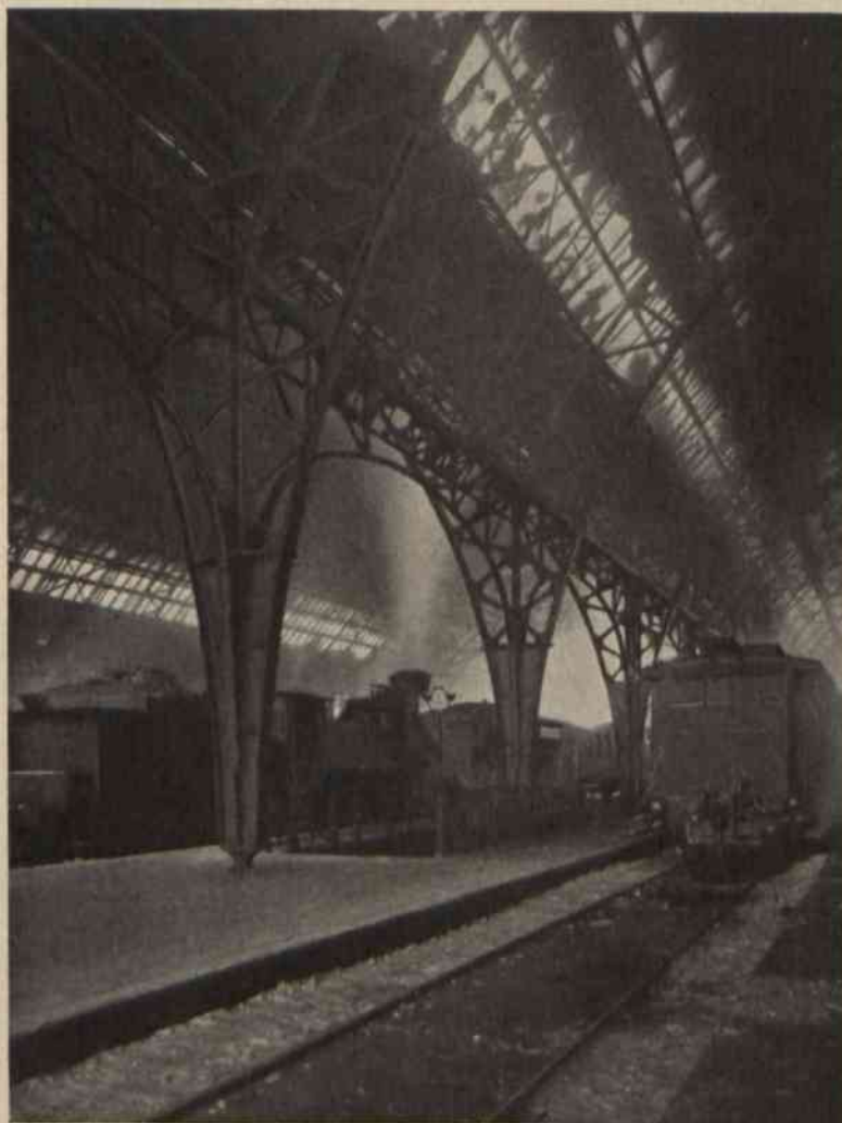
Konstrukcje żelazne hali dworca osobowego we Lwowie
