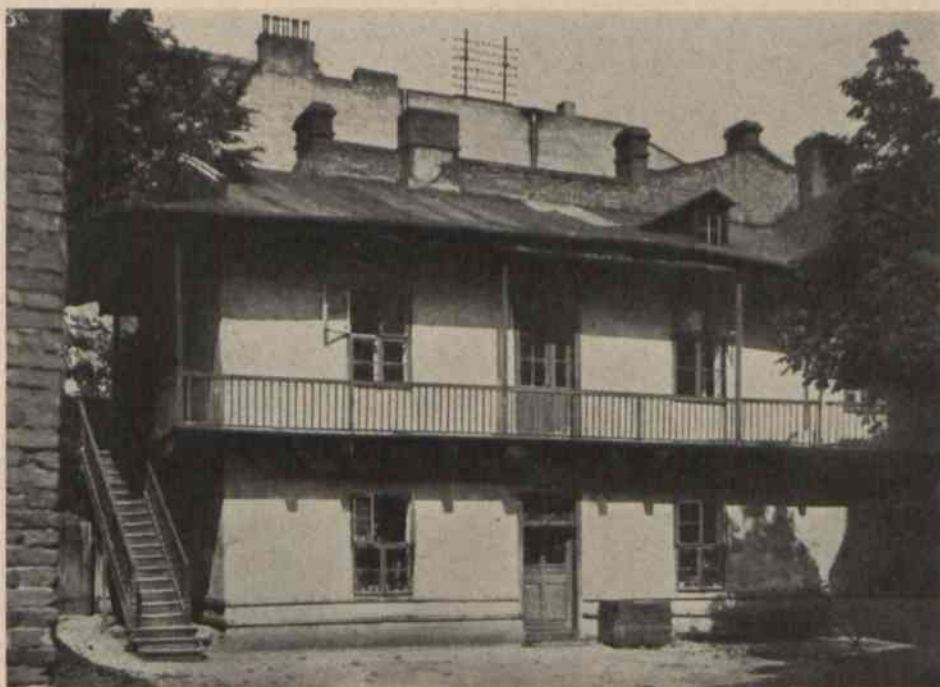
Oficyna domu przy ul. św. Marka 31, w której mieściło się od r. 1850 do r. 1886 biuro fabryki maszyn rolniczych L. Zieleniewski
