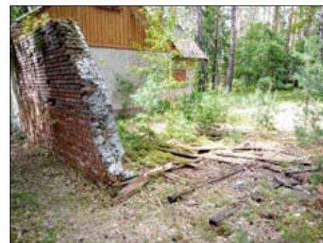
Fot. 4. Dawny budynek stacji kolejowej w wydziale 89 a. Fot. Michał Śliwiński
