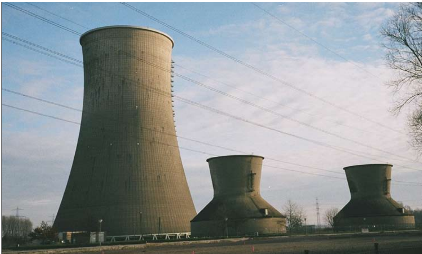
Fot.1. Elektrownia jądrowa w Hamm (Niemcy) wygaszona w roku 1989. Widoczne na zdjęciu istniejące obiekty przeznaczone są do rozebrania po gruntowym zmniejszeniu się promieniowania. Fot. Krystyna Haladyn (2008 r.)
