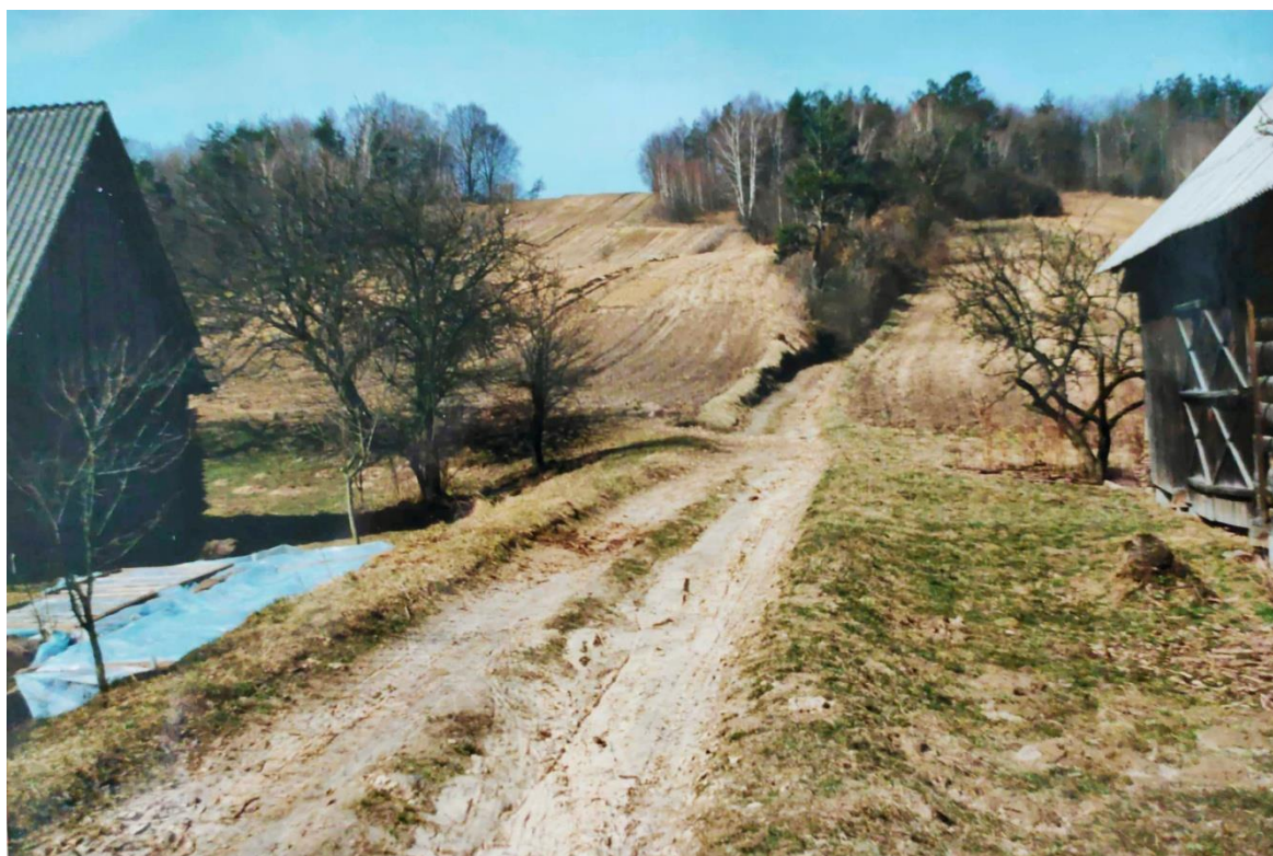
Fot. 24. Drogowy wał deluwialny u wylotu głębcznicy w Kawęczynie (fot. J. Rodzik)
