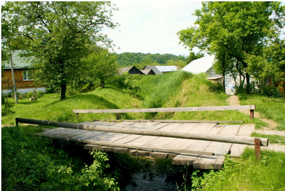
Fot. 25. Kanał odprowadzający wodę z suchej doliny w Kawęczynie podczas spływów powierzchniowych (fot. J. Rodzik)
