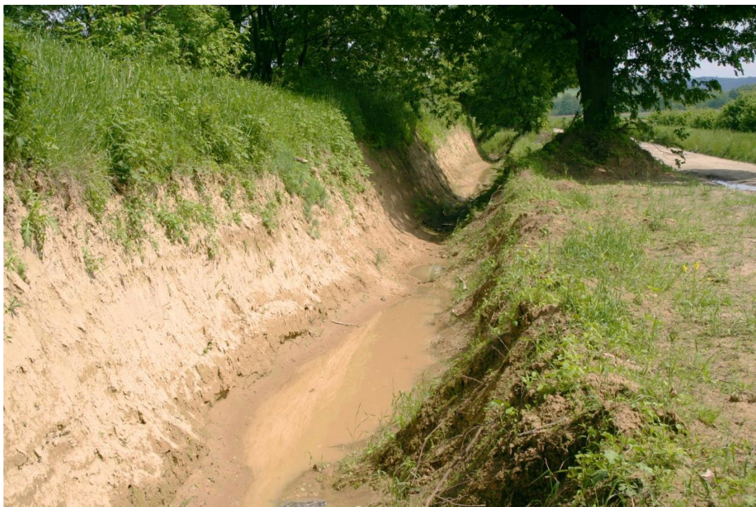
Fot. 26. Kanał odprowadzający wodę z suchej doliny w Kawęczynie podczas spływów powierzchniowych oraz wał osłonowy (fot. J. Rodzik)
