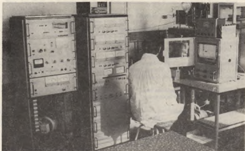
Ryc. 20. Dwukanałowy cykloidalny spektrometr mas do badania zjawisk jonizacyjnych w gazach, a również procesów dyfuzyjnych w materiale biologicznym
