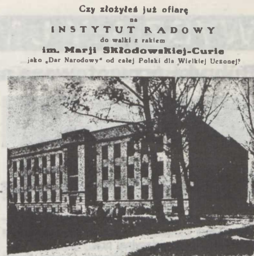
Stan budowy w dniu 1-go marca 1928 roku. Gmach już jest gotowy w stanie surowym. Brak jeszcze pół miliona zł na wykończenie.
