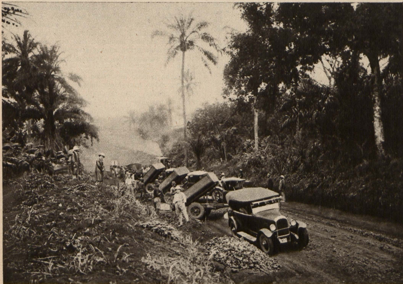
Budowa drogi w Kamerunie
