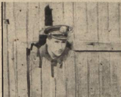
T. zw. „pancerne“ statki we Flotylli Pińskiej, były to statki uzbrojone i prowizorycznie osłonięte w najżywniejszych miejscach drewnianymi tarczami, pomiędzy którymi nasypywano piasek. Widzimy przebitą 6-calowym pociskiem taki pancierz na polskim statku Floty Rzecznej. Rok 1920.
