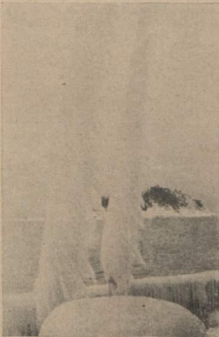
S/s. „Katowice”. Wanty (liny, utrzymujące maszt) pokryte grubą powłoką lodu.
