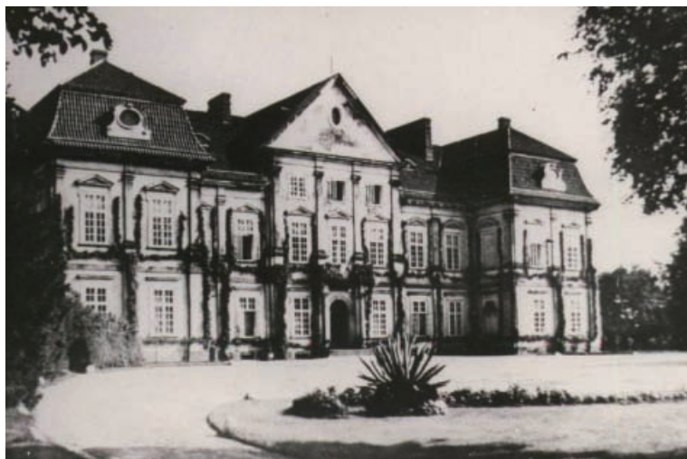
Ilustracja 3. Różanka, zachodnia elewacja pałacu. Stan z początku XX wieku. (Fot. w zbiorach p. Paprockiej, [za:] A. Obrębka, op. cit. )
