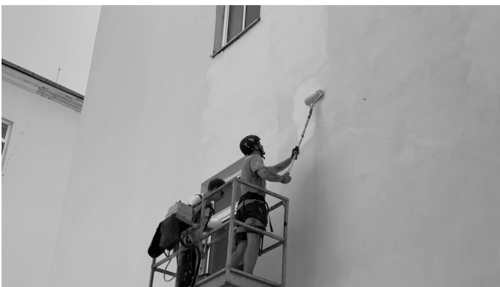
Zdjęcia z procesu malowania elewacji.
