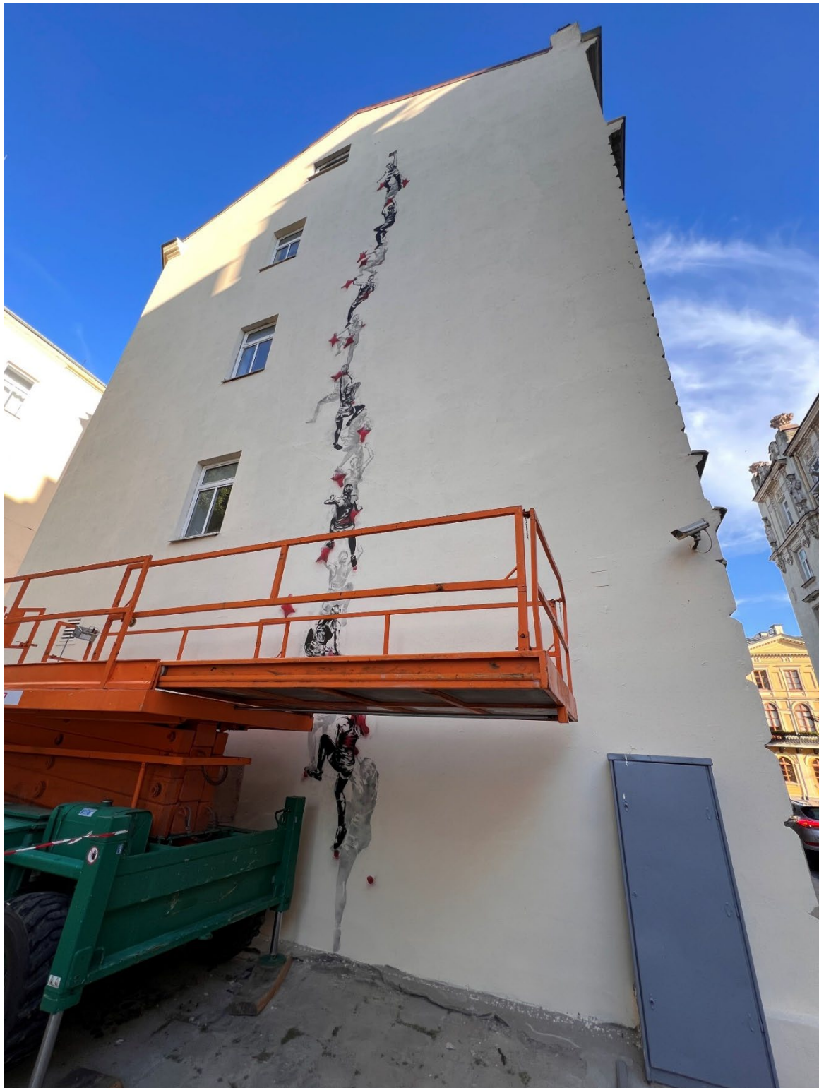
Widok elewacji po pierwszym dniu pracy (6.07.2024)
