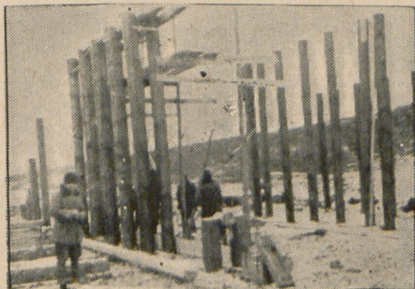
Pale wbito w dno rzeki, na których oprze się konstrukcja mostu; wieś Samborzec
