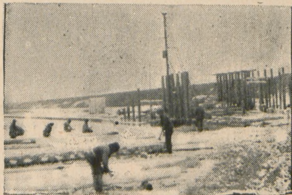
Budowa mostu na jednym z dopływów Wisły pod Sandomierzem
