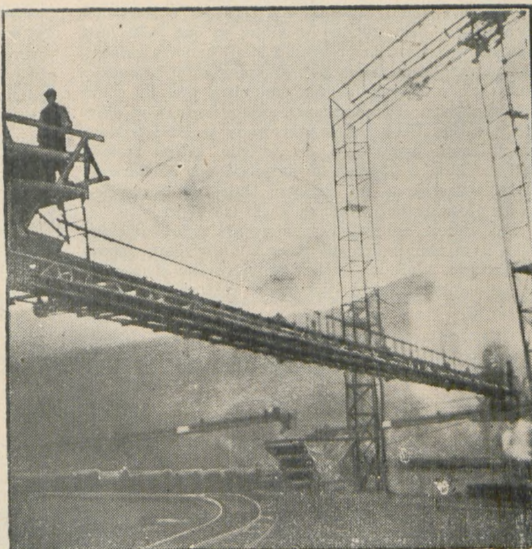
Kolejka powietrzna w Rożnowie dla transportu materiałów budowlanych
