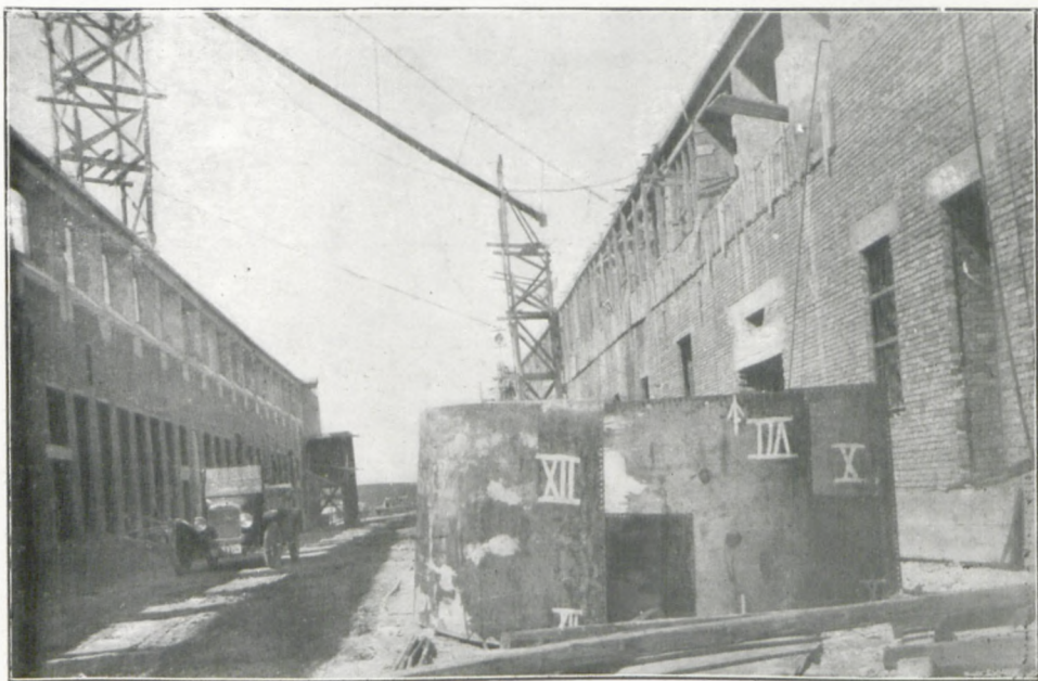
Rzeźnia lubelska. Hala łączna w lipcu 1927—jeszcze bez dachu—obecnie pokryta dachem.
