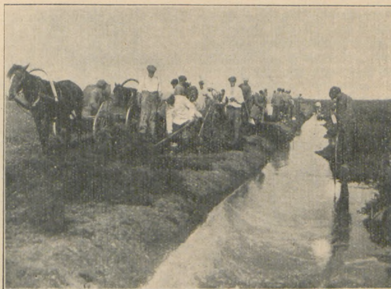
Budowa grobli przez błotne łąki na przestrzeni 8 km z jednoczesnym odwodnieniem na terenie gminy Kobryń.
