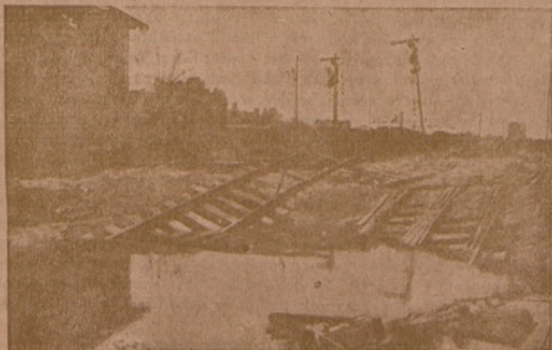
Obraz zniszczeń urządzeń kolejowych we Wrocławiu.
