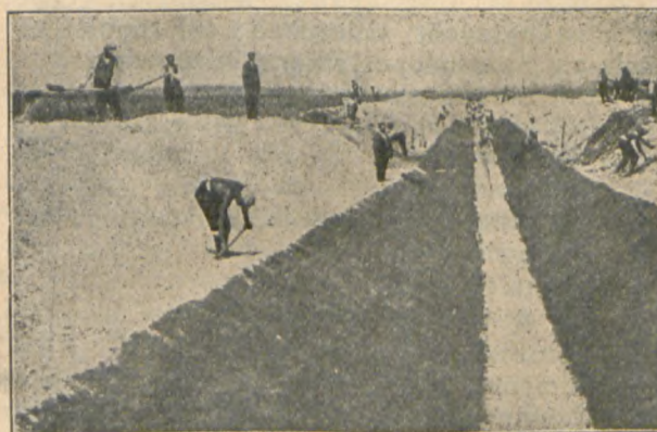
Ryc. 2. Do art. „Zapomniane meljoracje”. Kanał drugorzędny odwadniający.
