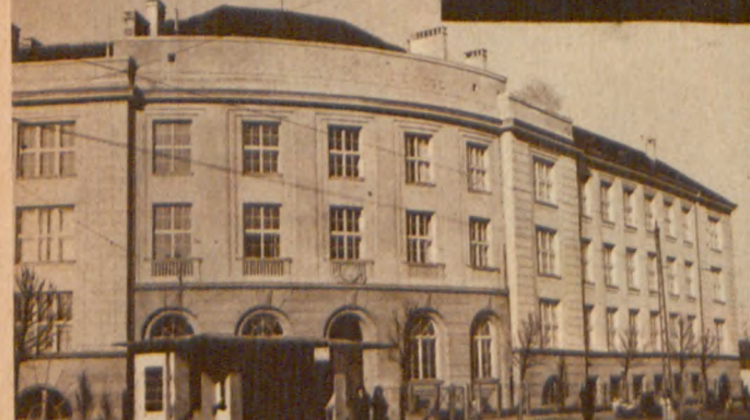
Gmach Szkoły Głównej Gospodarstwa Wiejskiego w Warszawie przy ul. Rakowieckiej. Szkoła ta kształci na inżynierów rolników, ogrodników i leśników
