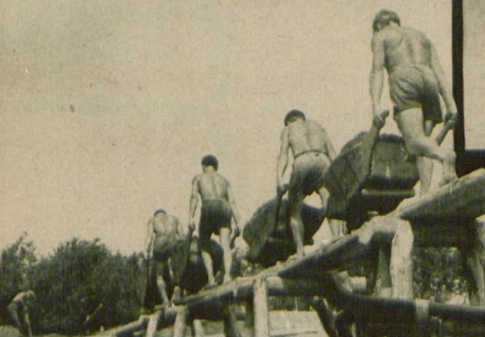
Prężą się mięśnie przy pracy nad obwałowaniem Wisły.
