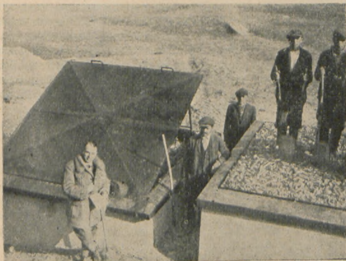
Zbiorniki do kiszenia z płynnym zamknięciem we Wrocławiu koło Lwowa.
