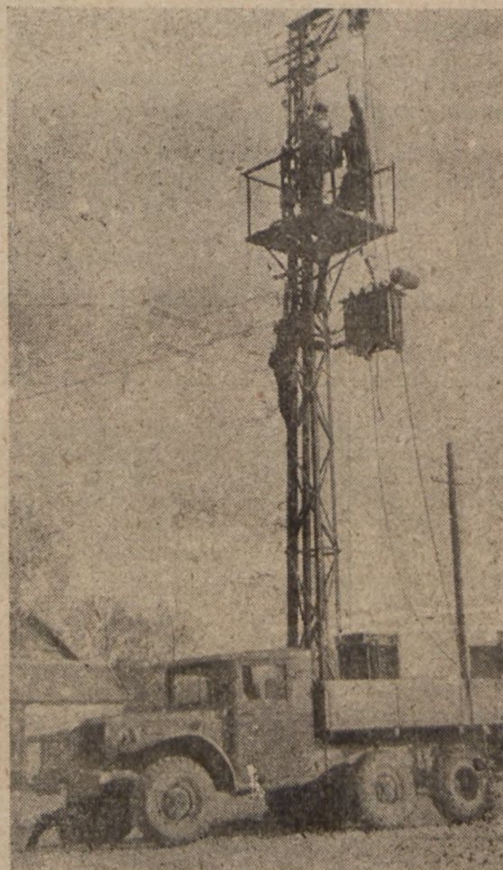
Białystok. Moment wymiany transformatoru. Praca Energetyków.
