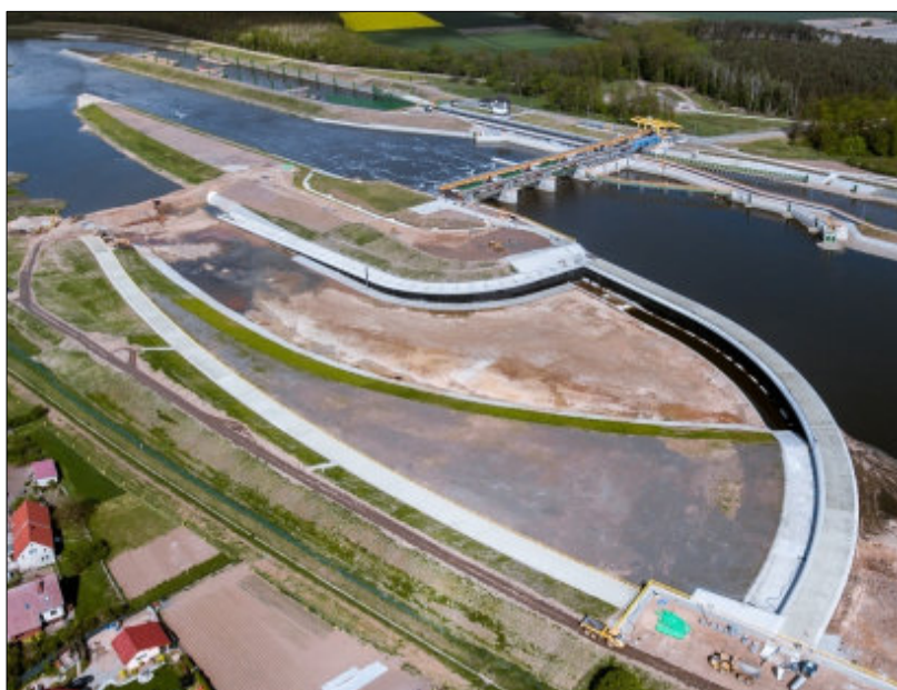
Ryc. 1. Widok z lewego brzegu Odry stopnia wodnego Malczyce na jaz stały, przepławkę dla ryb II i I, jaz ruchomy trzyprzęstowy kłapowy, elektrownię wodną, przepławkę dla ryb III, śluzę żeglugową, ujęcie wody i zbiornik wyrównawczy do nawodnień lasów. Źródło: https://www.cntsa.pl/oferta/realizacje,77/budowa-stopnia-wodnego-malczyce-na-rzece-odrze
