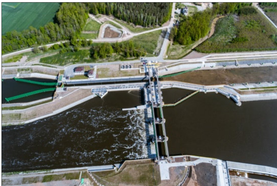
Ryc. 2. Na lewym brzegu: wlot i wylot przeplawki I (wokół przyczółka jazu) oraz na prawym brzegu, na wysokości śluzy: przeplawka III i zbiornik wyrównawczy podczas budowy. Źródło: https://www.cntsa.pl/oferta/realizacje,77/budowa-stopnia-wodnego-malczyce-na-rzece-odrze
