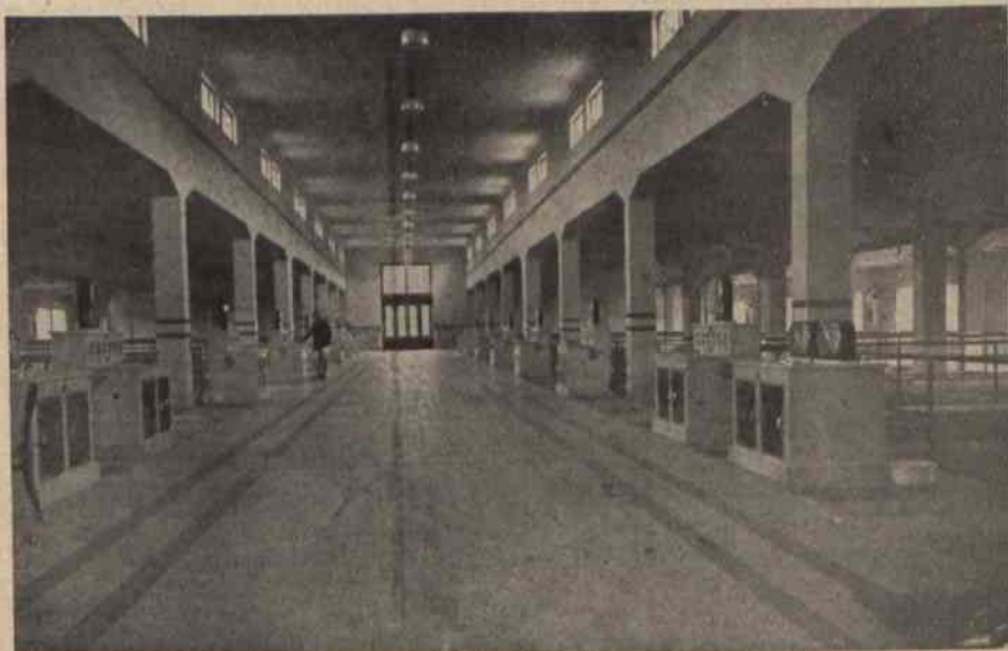
Zakład Filtrów Pośpiesznych. Wnętrze Hali Filtrów.
