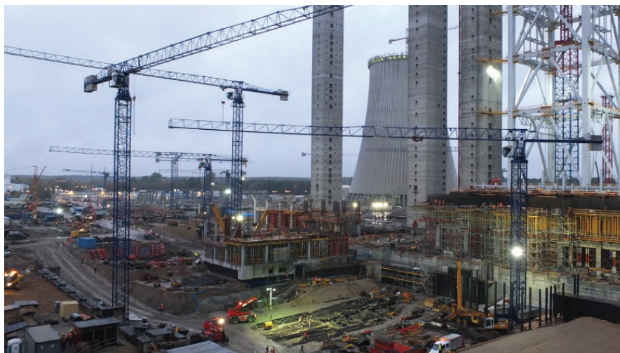
Rys. 4. Realizacja prac budowlanych na terenie PGE GiEK S.A. Oddział Elektrownia Opole
