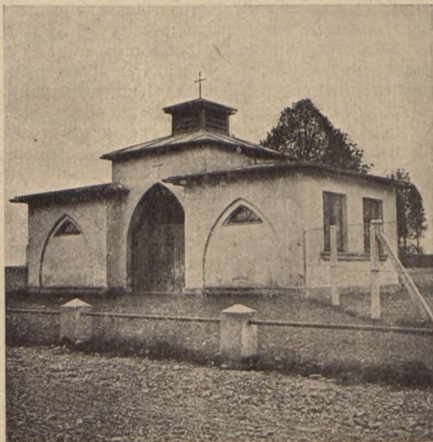
Ewang. kaplica cmentarna w Frydku, zbudowana w ub. roku.
