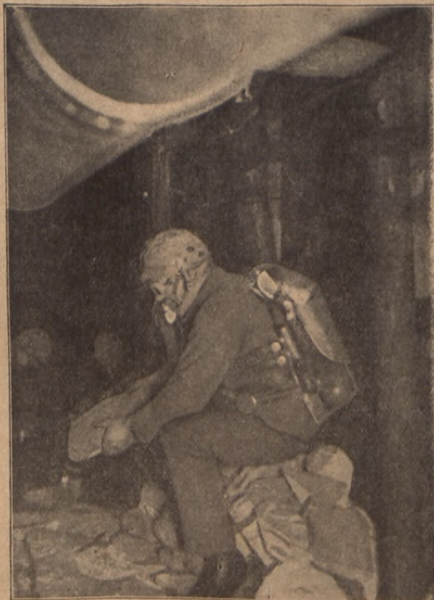
Odkopywanie drogi zasypanej z powodu wybuchu gazów.
