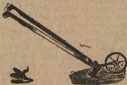
Rys. 2 — „Planet”, przystosowany do podcinania chwastów.
