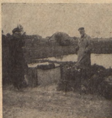
w. Boruny, pow. Oszmiana. Udostępnienie wody. Na pierwszym planie studzienka, ssawna do czerpania wody pożarowej.
