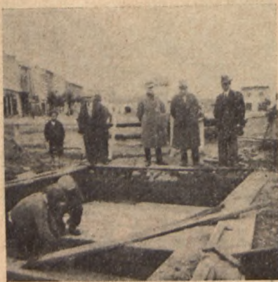
m. Halicz, pow. Stanisławów. Wykonanie płyty żelbetonowej nad zbiornikiem pożarowym.
