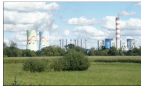
Fot. 4. Elektrownia Opole. Fot. Aureliusz Miklaszewski
