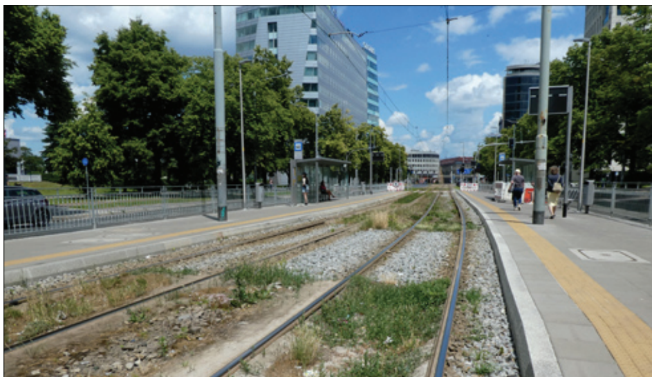
Fot. 1. Wydzielone torowisko pozwala na szybszy przejazd tramwaju. Fot. Krystyna Haladyn
