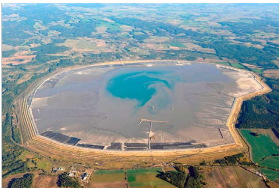
Fot. 1. Obiekt Unieszkodliwiania Odpadów Wydobywczych „Żelazny Most” widok z lotu ptaka. Widoczne części plaży przykryte emulsją asfaltową oraz staw wody nadosadowej.
