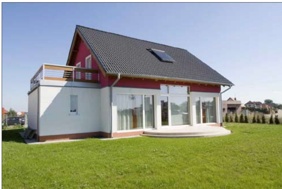
Fot. 1. Dom pasywny w podwrocławskim Smolcu. Fot. Aureliusz Mikłaszewski
