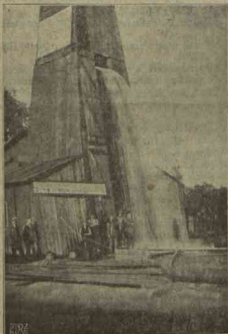
Wiercenie na termę w Clechocinku głębokość 1200 m samowpływ 250 m 3 /godz.
