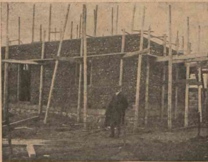
Dom z gliny nieprzerabianej przy zastosowaniu cpałdów drzewa.
