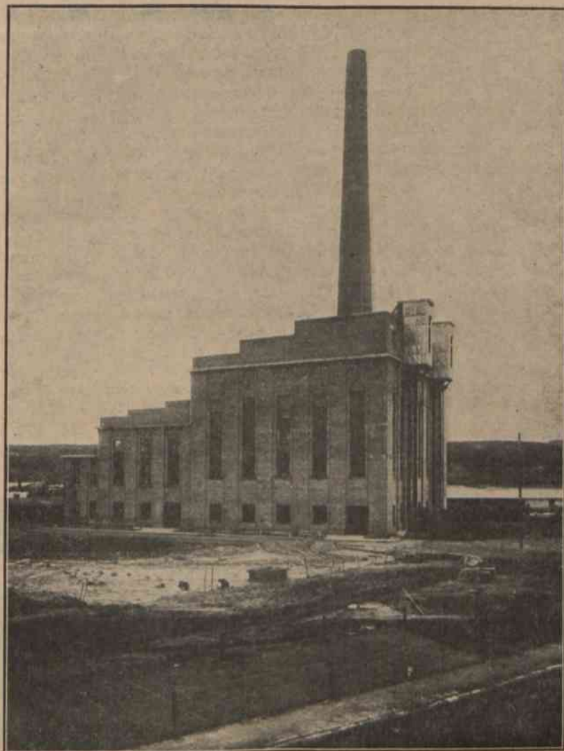
Kujawska Elektrownia Okręgowa we Włocławku. Widok ogólny.
