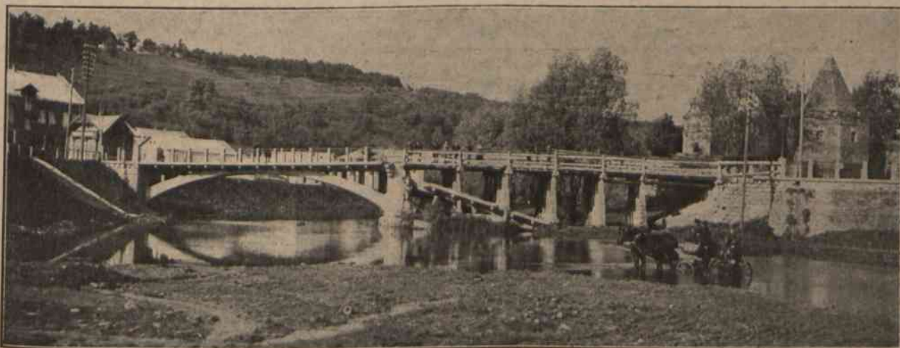
Powiat Trembowla. Most na drodze powiatowej żelaznobetonowy na rzece Gnieźnie w Trembowli, zbudowany w r. 1904. Połowa zniszczona w 1915 roku, obecnie odbudowuje się kosztem 50.000 zł.
