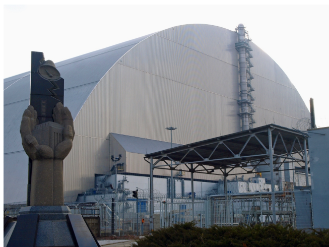
Rys. 14. „Nowa Arka” Pod kopułą znajduje się stary sarkofag wraz ze zniszczonym reaktorem (źródło: materiał własny).
