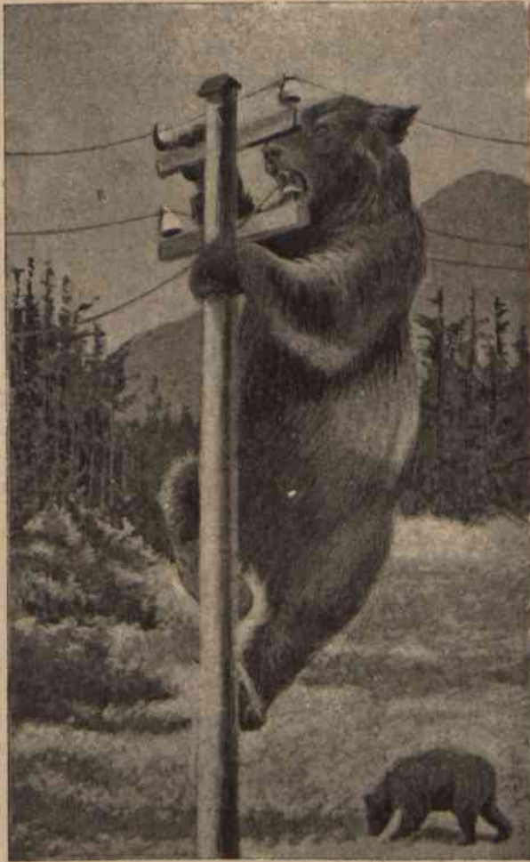
Niedźwiedź zrywa izolatory drutów.
