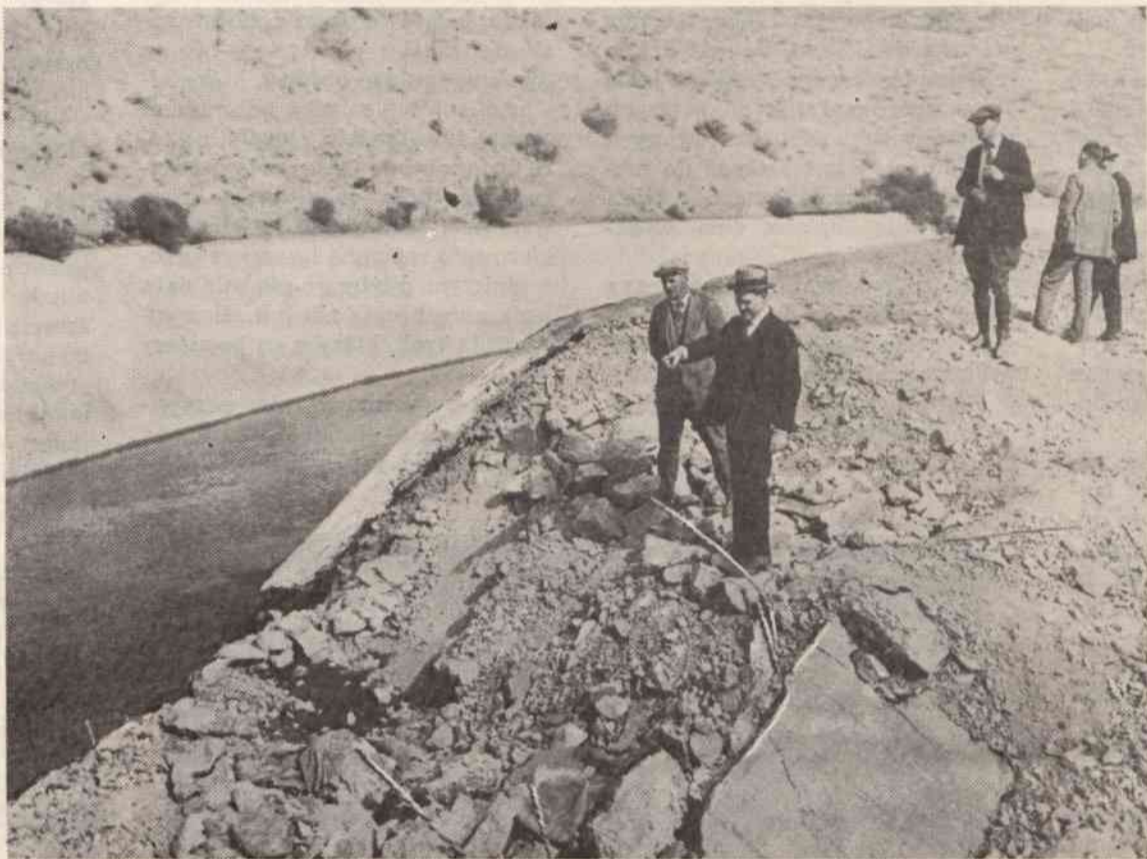
WYSADZENIE WODOCIĄGU miejskiego przez niewysiedzonych zbrodniarzy, wzniesło ogólny przestrach w Los Angeles. Przewód ten może zaopatrzyć w wodę do picia ludność dwu milionową i nawodnić 135,000 akrów ziemi. Ciągnie się przez 280 mil i kosztował dwadzieścia pięć milionów dolarów. Może też wydać siłę elektryczną około 200,000 K. M. Przy budowie trwającej dziesięć lat, od 1904 do 1913 roku, pracowało stale około 4,000 ludzi. — A teraz znalazła się zbrodnicza ręka, która chciała zniszczyć to wspaniałe dobroczynne dzieło!... Na szczęście wyrażona szkoda dała się szybko naprawić. — Policja jest podobno na tropie zbrodniarzy. Podejrzanie pada na tych włóczęgów, którzy pod pozorem szukania roboty, tysiącami napływają do południowej Kalifornji, i których miejscowa policja codziennie setkami aresztuje i przymusowo wypędza. Zachodzi więc, jak przypuszczają, wypadek osobistej zemsty, za którą miało odpokutować całe miasto.
