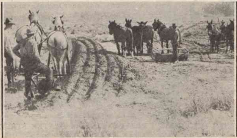
BUDOWA NOWEGO MIASTA w plaskach Los Angeles. Wedle obliczeń kolejowych przeszło 10,000 ludzi przyjeżdża do L. A. każdego miesiąca. Stąd brak mieszkań. Więc powstają nowe miljonowe przedsiębiorstwa budowlane, które zakupują ziemię na pustyni, otaczającej L. A., zakładają przedmieścia, budują ullice, kanały i domy, i spekulacja podobno się wyplaca.
