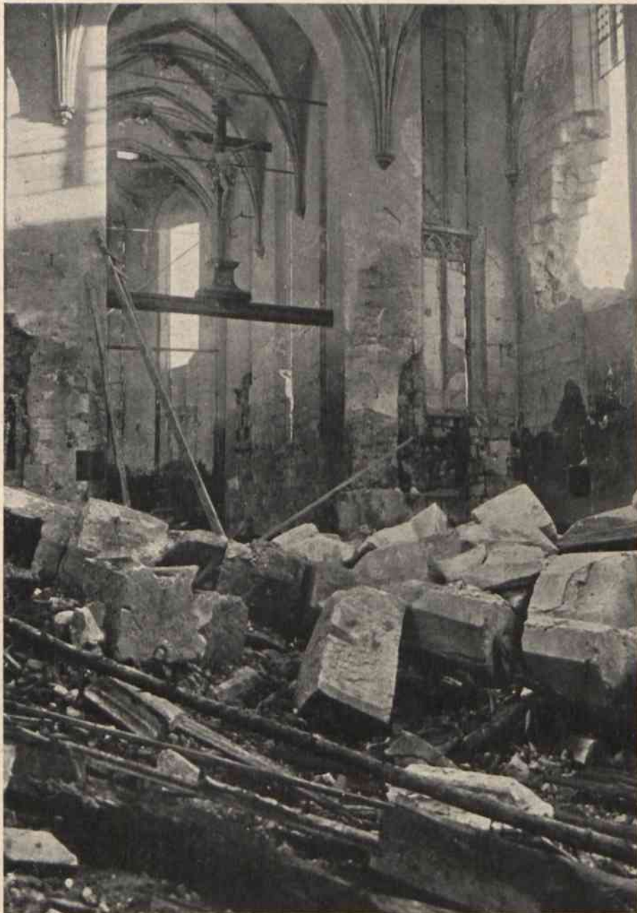
Ryc. 100. Wislica. Kościół kolegiacki. Wnętrze nawy z prezbiterjum. Po zniszczeniu wojennem.
