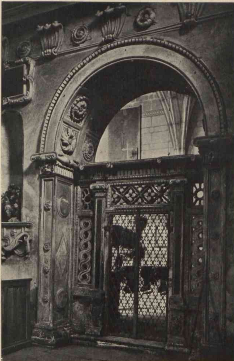
Ryc. 135. Bejsce. Kościół św. Mikołaja. Wejście do kaplicy.
