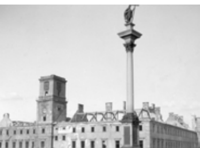
Warszawa, ruiny Zamku Królewskiego / Fot. NAC
