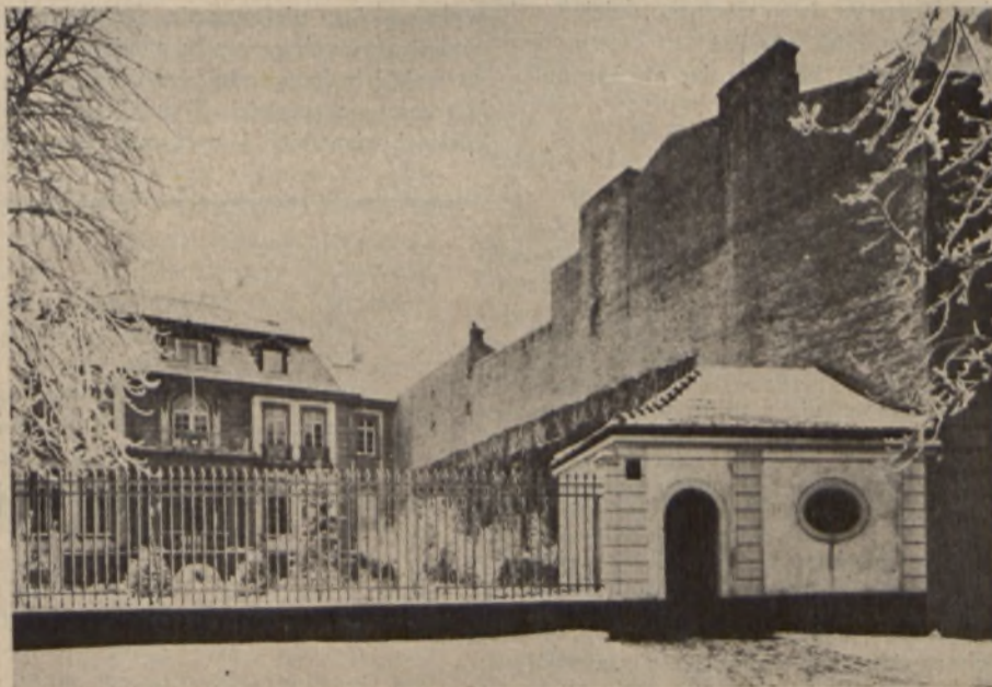
Pałacyk w Alei Szucha na tle ściany szczytowej sąsiedniej kamienicy.
