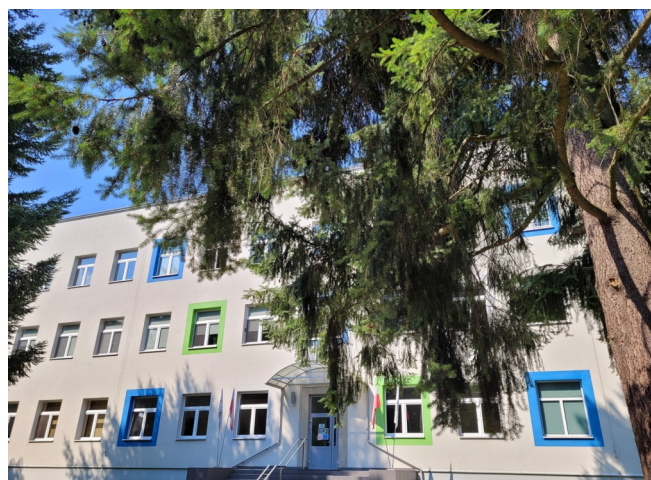
Fot. 1. Siedziba ZUOP.
