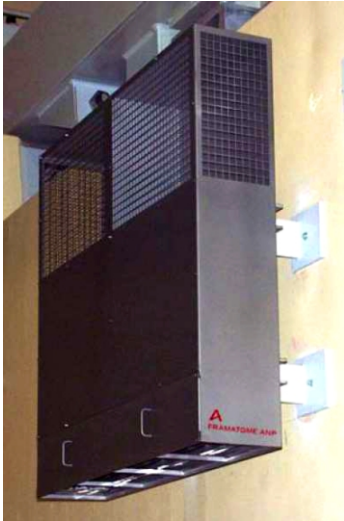
Rys. 13. Pasywny autokatalityczny rekombinator wodoru (AREVA) [2].
