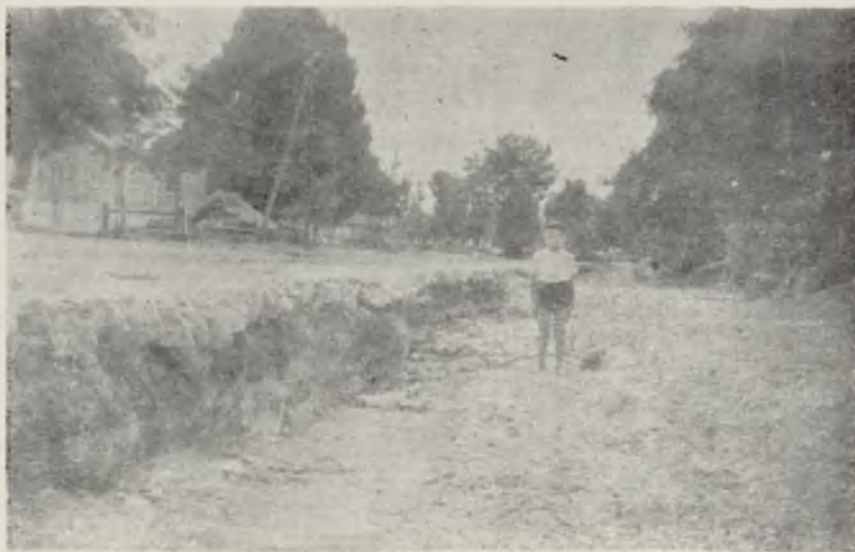
FOT. 2. Szerokie koryto erozyjne podcinające szosę na dnie doliny głównej. Piaski Szlacheckie.
