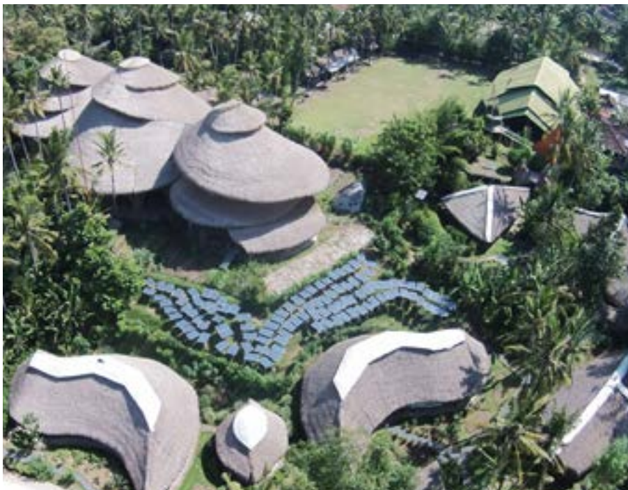
Widok na The Green School w Bali, Indonezja, gdzie wykorzystuje się wiele „zielonych” technologii w codziennym funkcjonowaniu placówki, m.in. hydropanele Source (które przy pomocy energii słonecznej uzyskują wilgoć z powietrza) służące do produkcji wody pitnej dla studentów i personelu szkoły Źródło: WIPO Magazine
