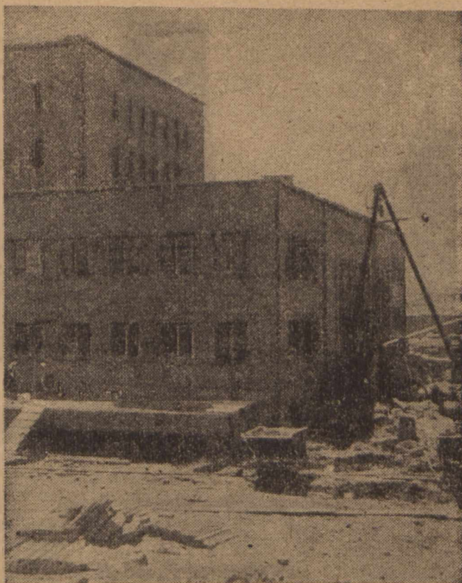
Kühlhaus Lemberg im Bau
