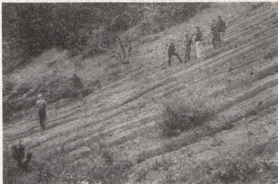
Ryc. 1. Prawe zbocze niszy osuwiska. Badland w łupkach ilastych Right side of the rock scarp of the landslide. Badland in the loamy slates
