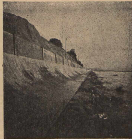
Gdynia. Betonowe umocnienie bulwara pod Kamienną Górą. Fot. H. Gąsiorowski.
