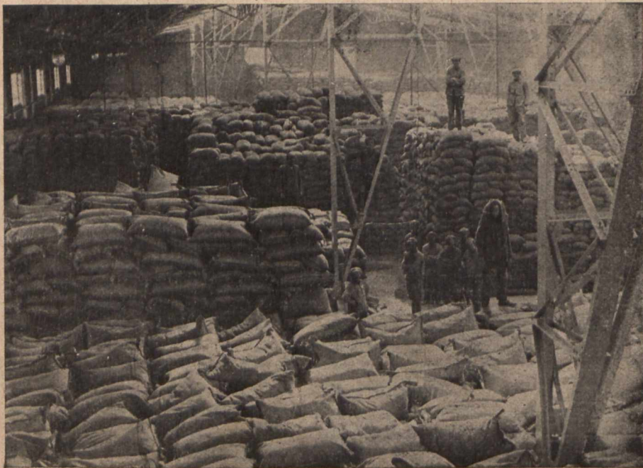
Gdynia. Wnętrze jednego z magazynów portowych.
