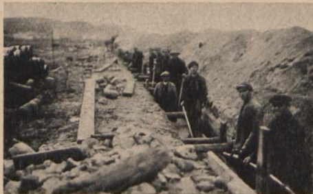
Gdynia. Zakładanie kanalizacji i wodociągów.
