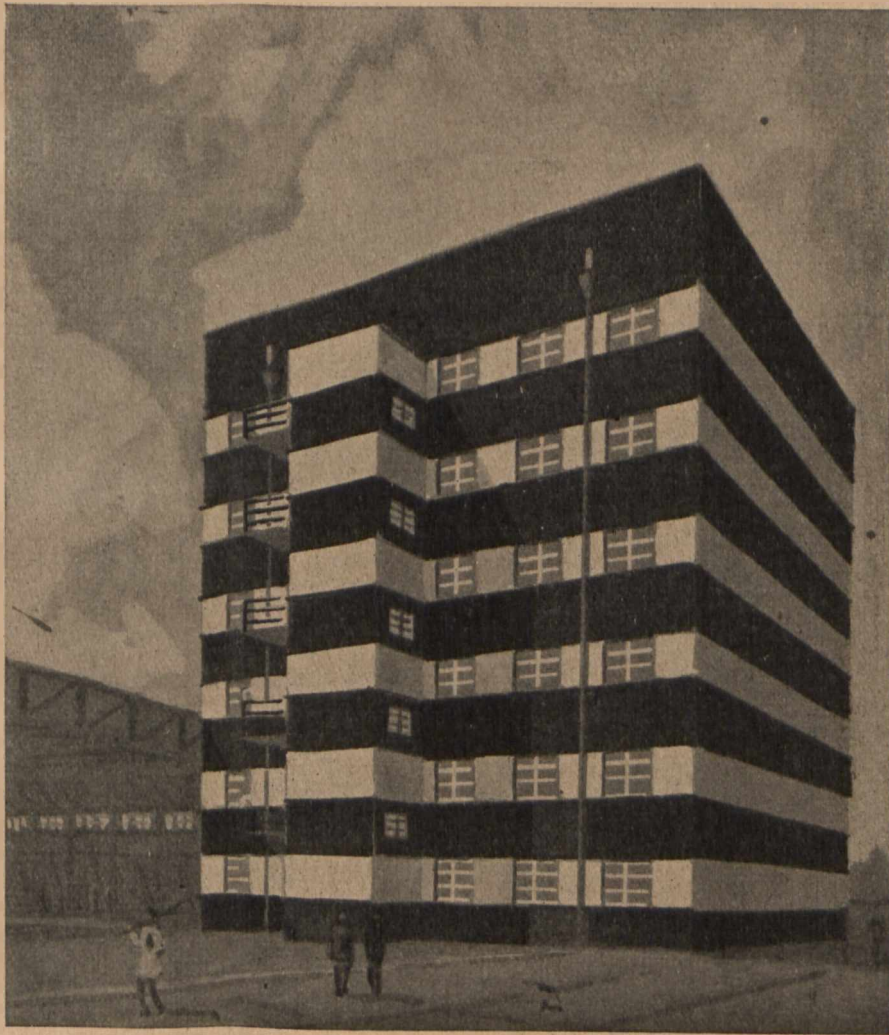
Tak będzie wyglądała łuszczarnia ryżu w porcie gdyńskim, która obecnie znajduje się w budowie.
