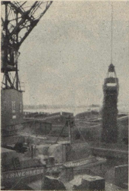
Vlaardingen. Ładowanie węgla przy pomocy chwytacza.
