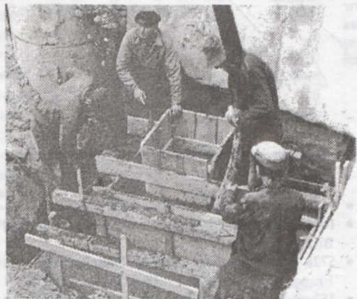
Pierwsze prace przy wznoszeniu gmachu dla Wydziału BiNoZ
